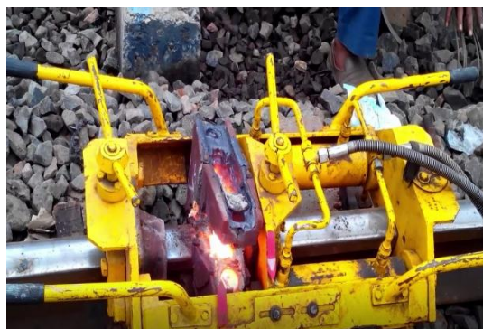
ขั้นตอนที่ 2 กำจัดเนื้อเหล็กหล่อเชื่อมส่วนเกินออก
