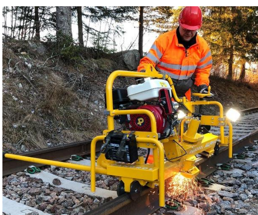
ขั้นตอนที่ 4 ตกแต่งเหล็กรางเชื่อมด้วยการเจียรระโน
