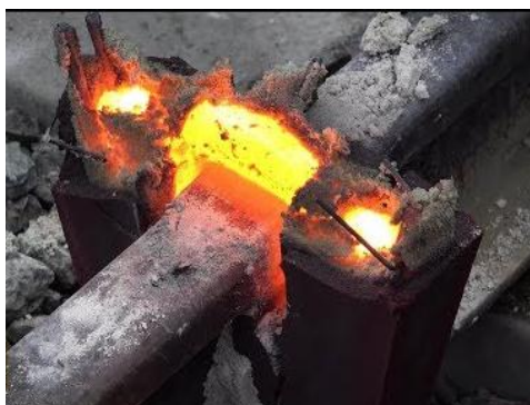
ขั้นตอนที่ 1 น้ำเหล็กหล่อเชื่อมเย็นตัว
