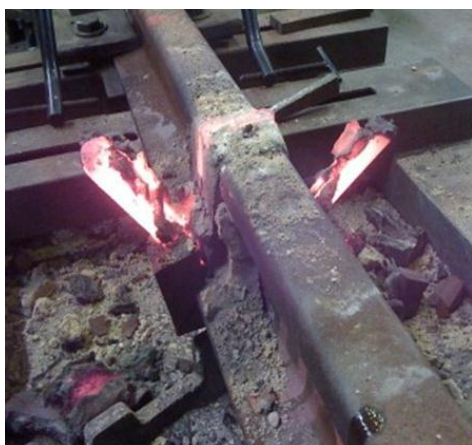
ขั้นตอนที่ 3 เหล็กรางเชื่อมเสร็จ
