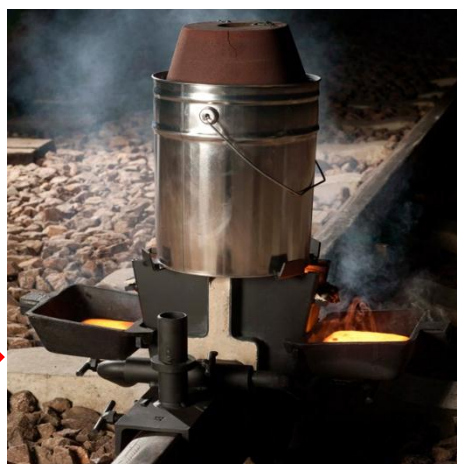
รูปที่ 4.85 ชุดส่วนประกอบของอุปกรณ์ขบวนการเชื่อมเทอร์มิตรางรถไฟ
